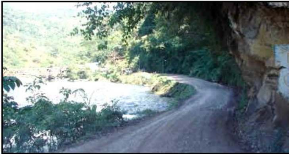
FIGURA N°03: PELIGROS DE DESLIZAMIENTO Y DESPLOME DE LA CARRETERA HACIA EL SECTOR DE RAYMONDI DEBIDO A LA EROSION Y SOCAVACION DEL RIO POR LOS CAMBIOS DE DIRECCION DE LOS MATERIALES SEDIMENTADOS TRAJIDOS EN LOS AUMENTOS DEL CAUDAL
